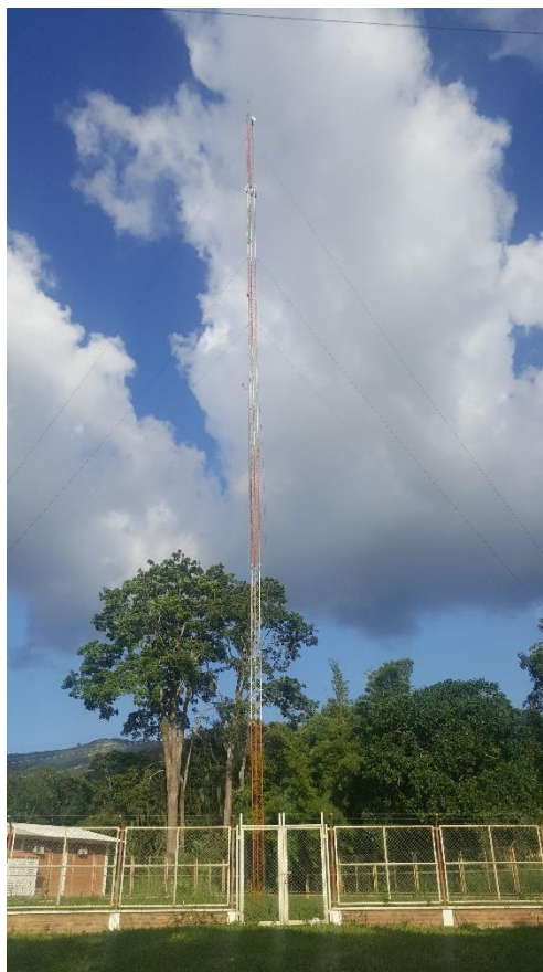
Figura 13. Vista de la torre de telecomunicaciones de la UFPSO.
