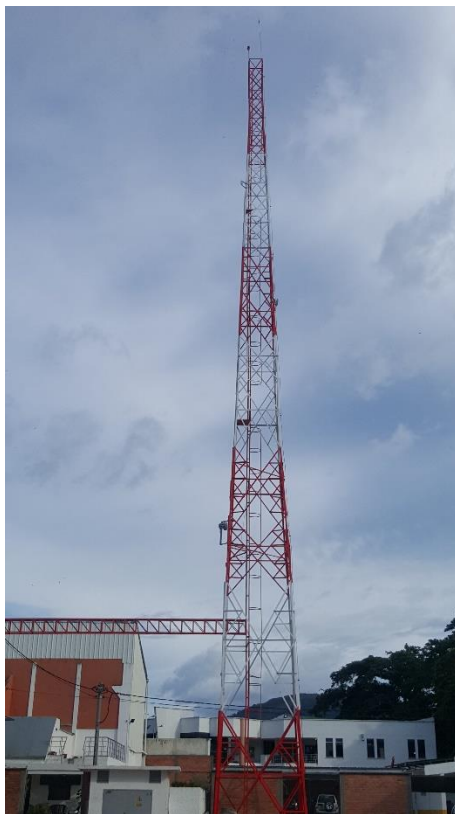
Figura 11. Vista de la torre de la Sede la Primavera.
