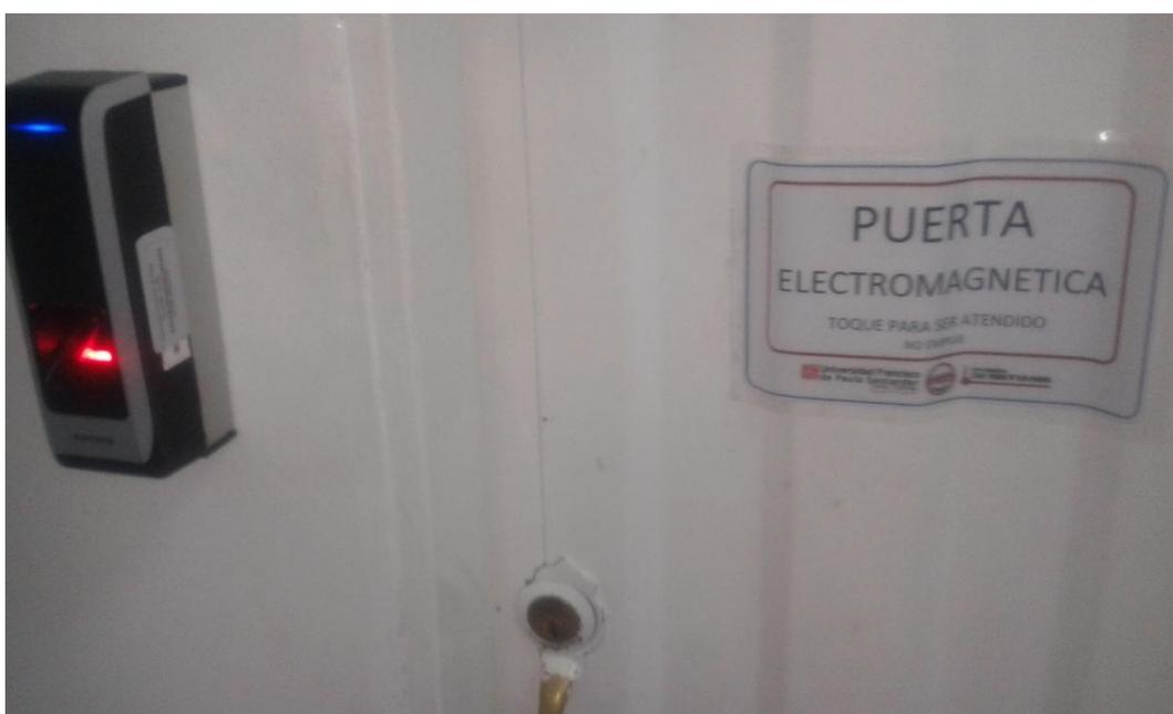
**Figura 53. Sensor en estado pendiente, sala de servidores. Fuente autor.**
