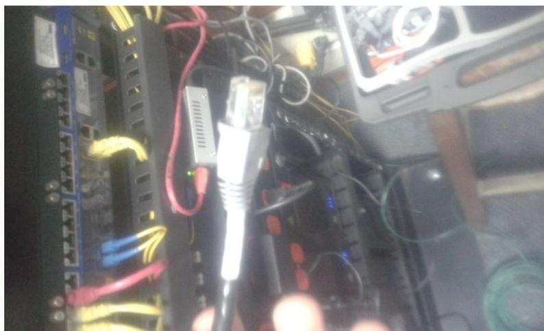
**Figura 26. Cable UTP CAT6 con topología conexión directa y conector RJ45. Fuente autor**
