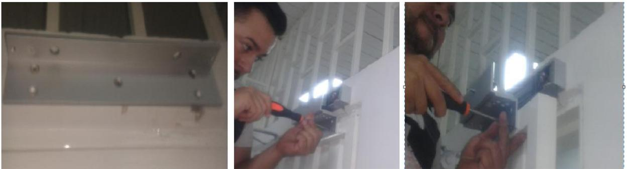
**Figura 88. Instalación soporte en puerta para barra metálica. Fuente autor del proyecto.**
