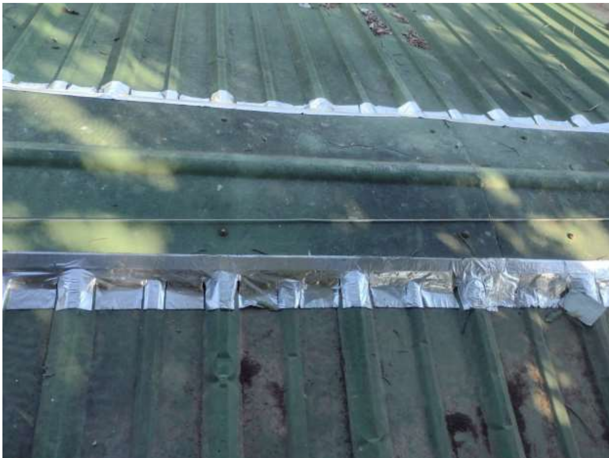
Figura 13 Reacondicionamiento de cubierta con cinta asfáltica Sika multiseal
