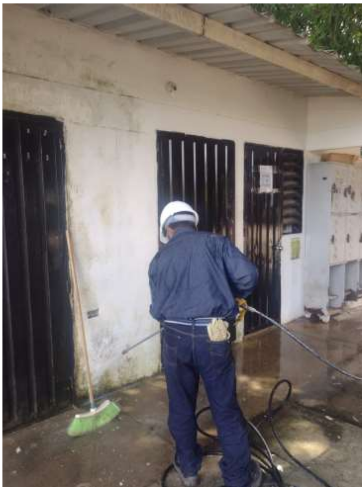
Figura 4 Preparación de muros externos- lavado mediante hidro lavadora
