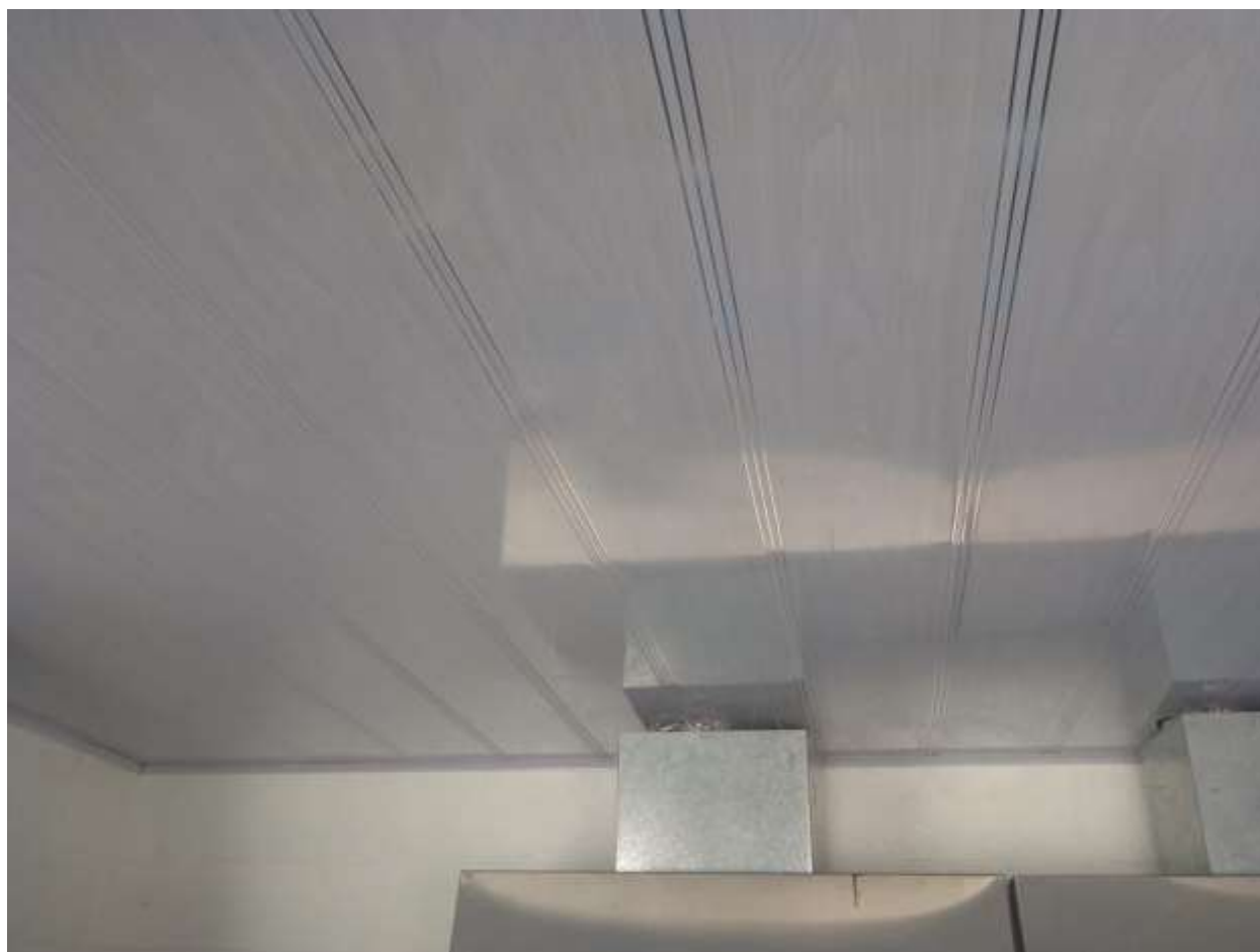
Figura 12 Instalación de cielo raso PVC
