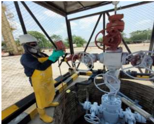
Figura 61 Aplicación de Primer epóxico HS 2K sobre cabezales de pozo de inyección y producción (O.T 8000002206 – Pintura de pozos productores e inyectores Pad 5, Pad 4 y Pad sur)
