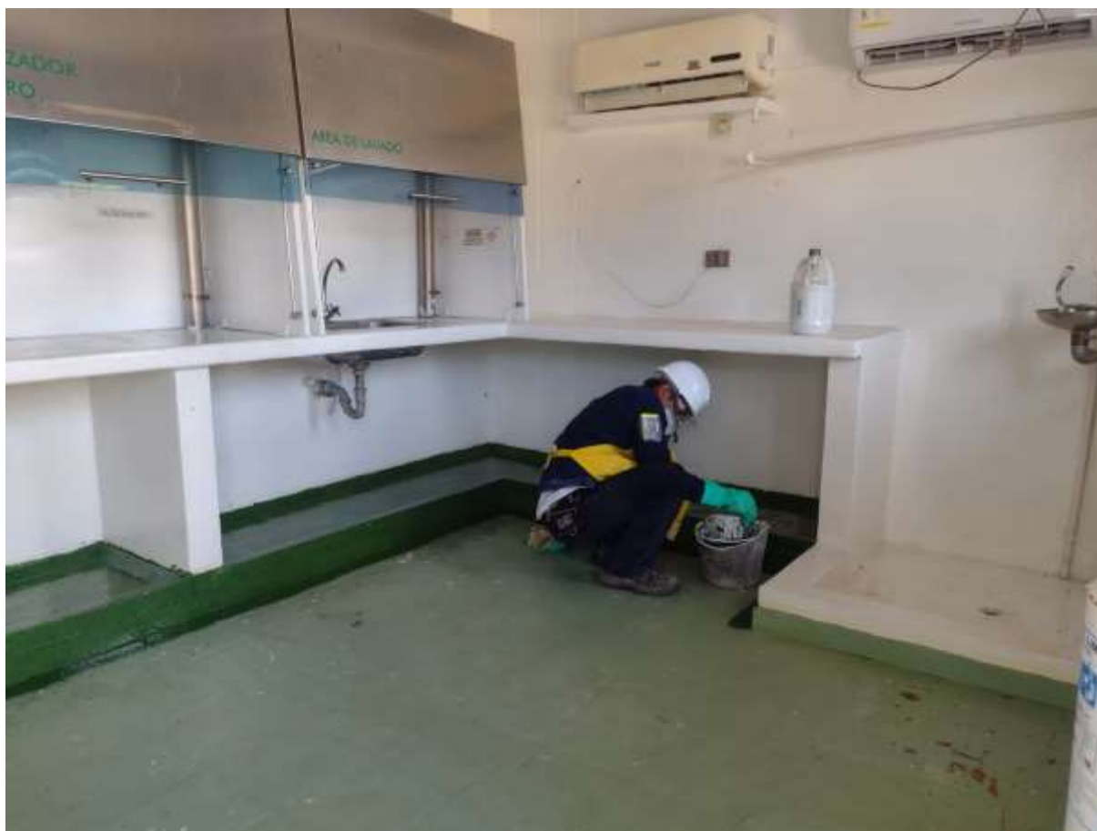
Figura 7 Aplicación de pintura epoxica sobre piso del laboratorio
