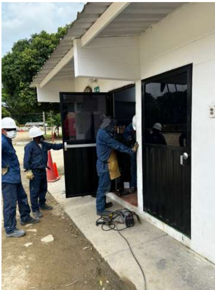
Figura 9 Desmonte y monte; sandblasting, pintura de puertas y marcos metálicos
