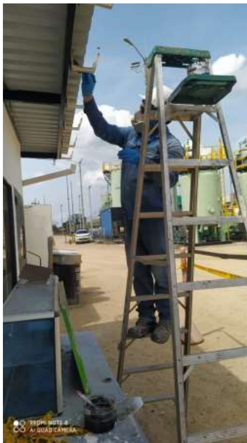
Figura 11 Protección de estructura de cubierta con anticorrosivo
