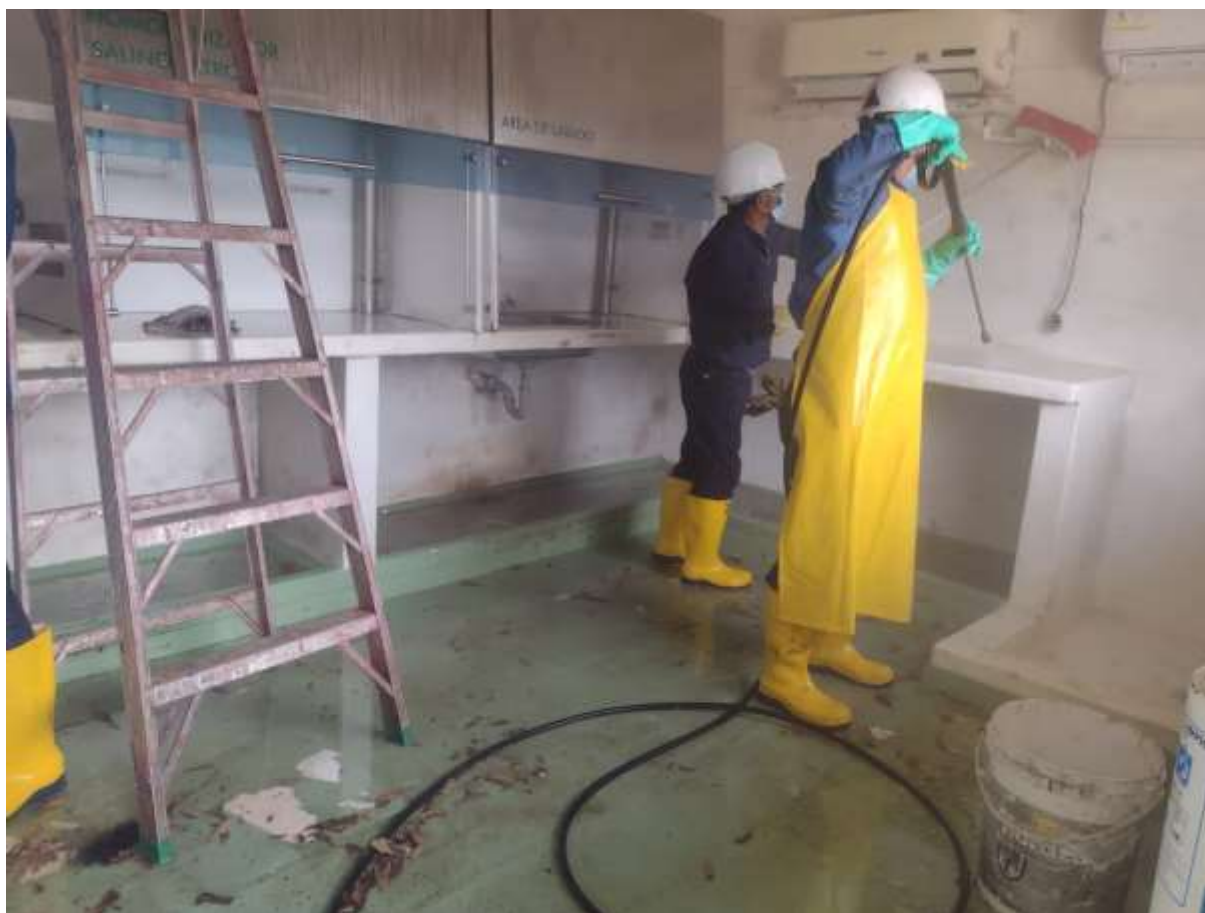
Figura 6 Preparación de muros externos-lavado mediante hidro lavadora 2
