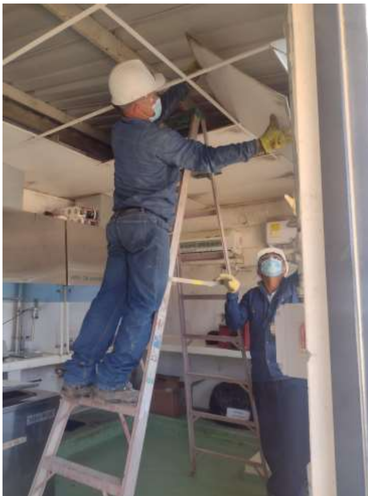
Figura 3 Desmantelamiento cielo raso poliestireno expandido
