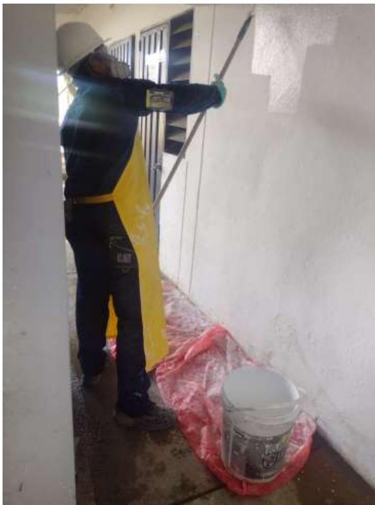
Figura 5 Pintura de muros exteriores
