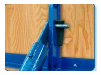
Nota. Son elementos que permiten que se ancle el muro al piso. (Forsa, 2022)
