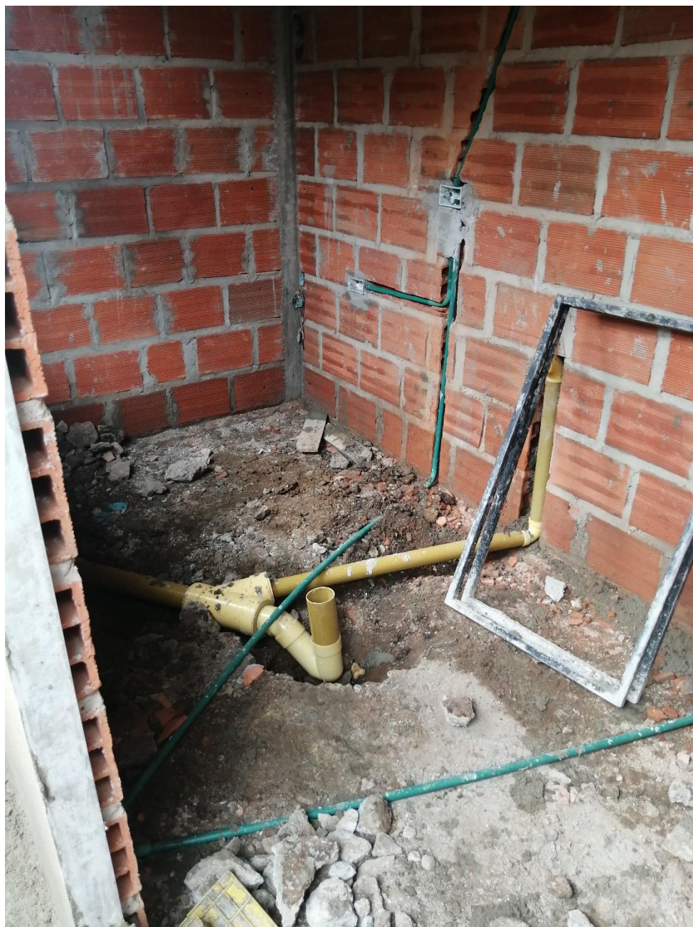
Nota. Instalación de puntos eléctricos. (Unión Temporal Vale Rio de Oro, 2021)
