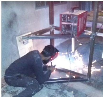
Ilustración 46. Refuerzo estructura de arrastres
