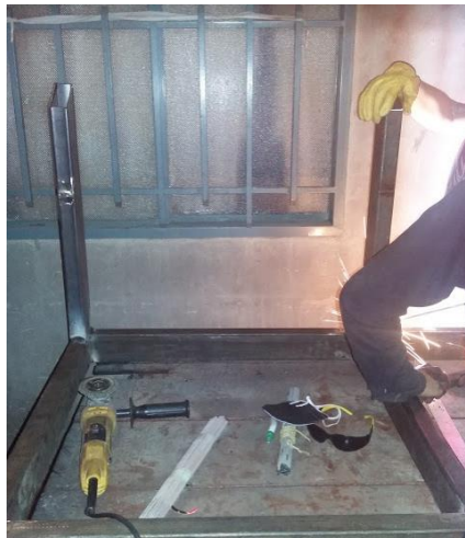
Ilustración 44. Refuerzo de poste
