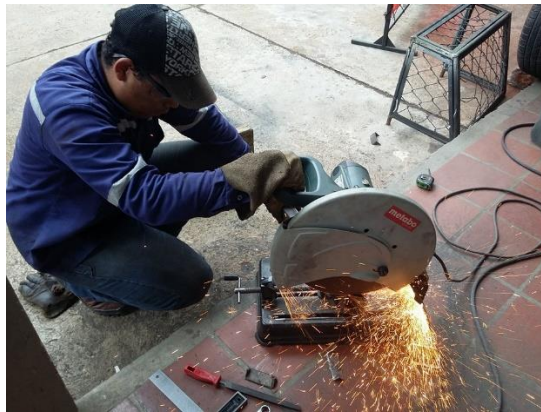
Ilustración 40. Corte de tubería
