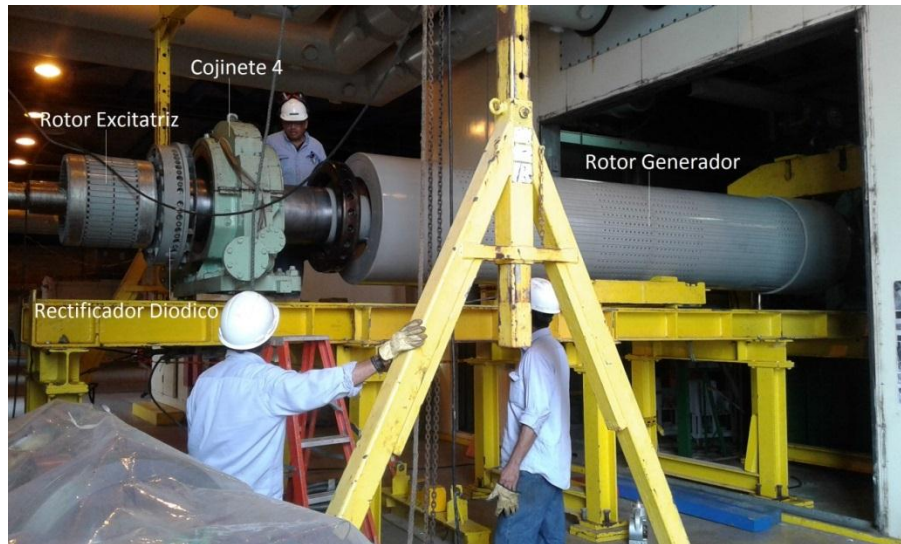
Figura 29. Rotor Generador
