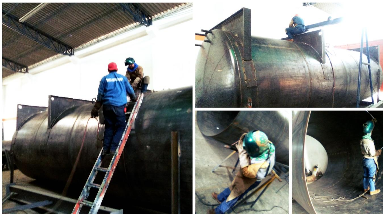
Figura 26. Implementación de EPP
