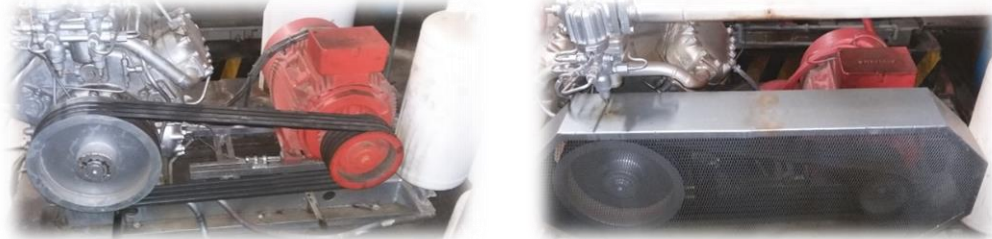
Figura 44. Compresor alternativo SABROE SMC 6/100 y 4/100 (vista perfil)
