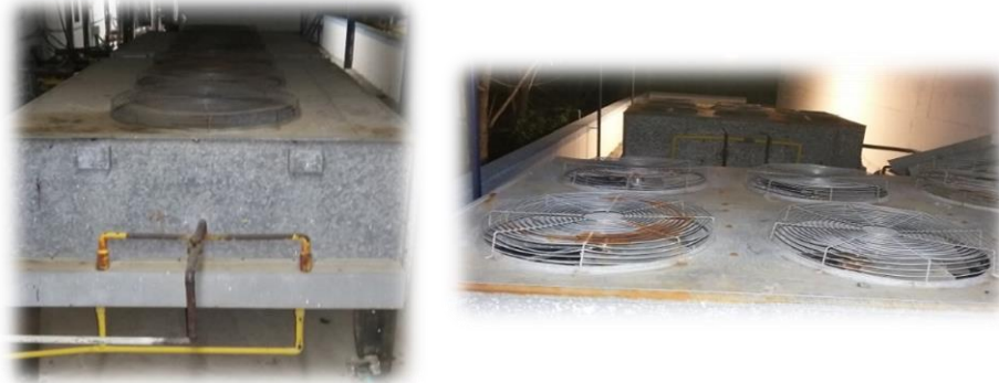
Figura 49. Condensadores de tiro forzado
