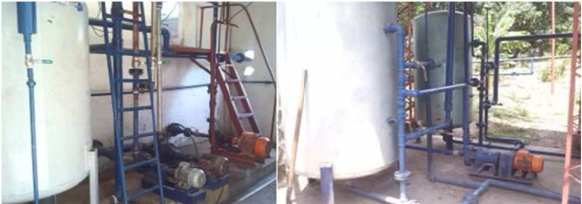
Fotografía 15. Sección de acueducto y tratamiento de aguas.
