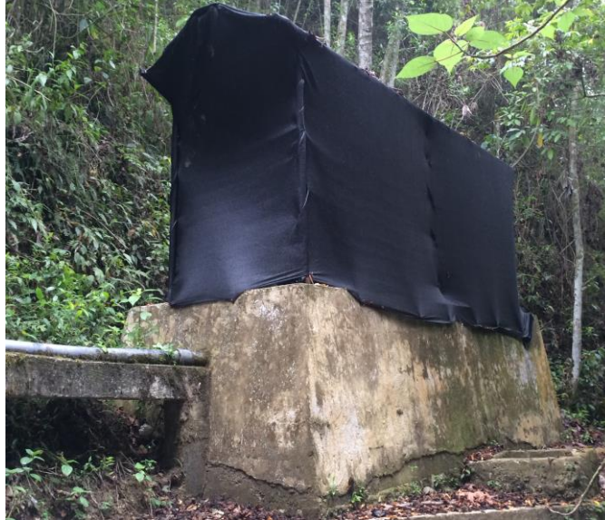
Imagen 6. Desarenador quebrada La Toma.
