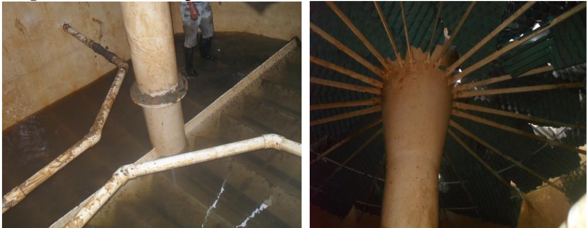
Imagen 20. Mantenimiento general al Clarificador.
