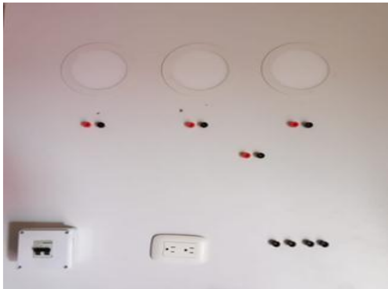
Figura 65. Lámparas, borneras, breaker y tomacorriente instalados en el tablero del banco. Fuente. Autor del proyecto
