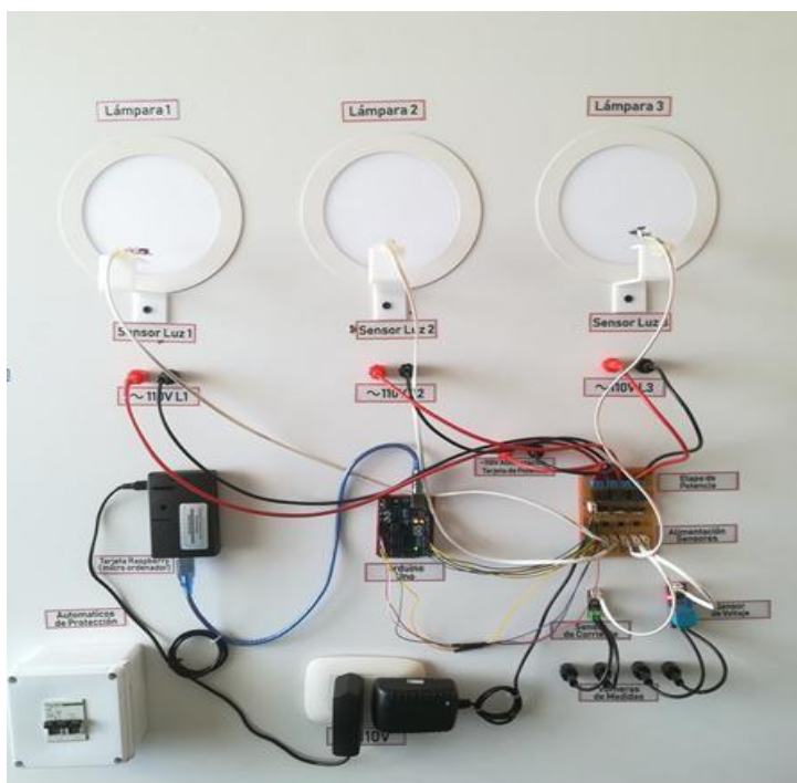
Figura 67. Tablero con todos sus componentes Fuente. Autor del proyecto
