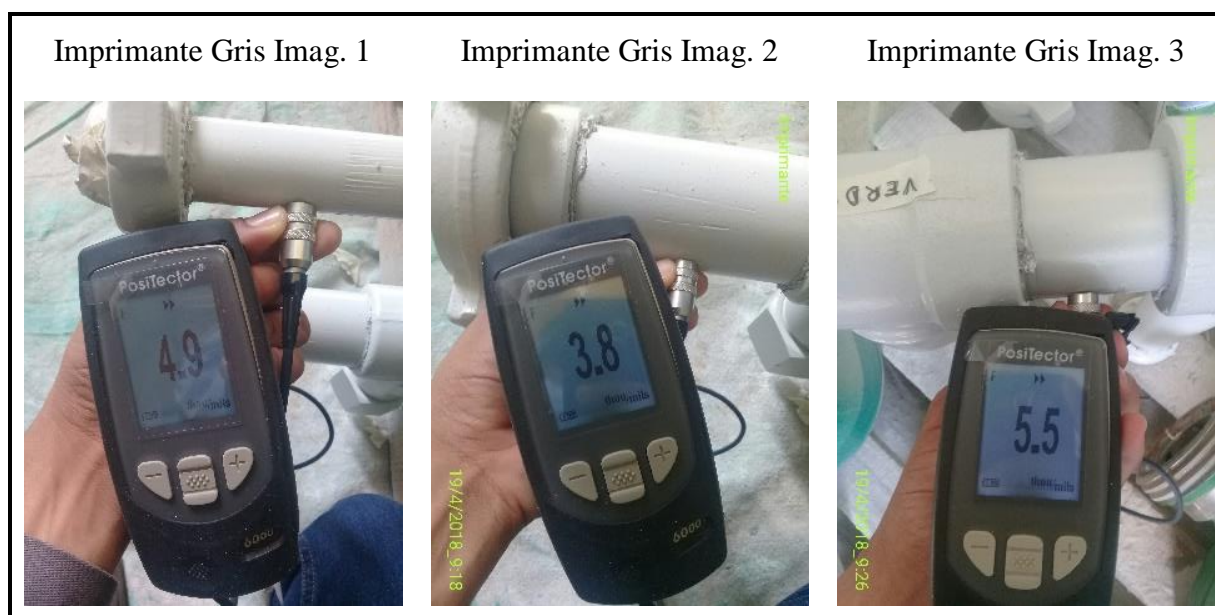
Figura 43. Espesor de pintura a los Spool del cabezal de pozo. (Tipo de pintura: imprimante)
