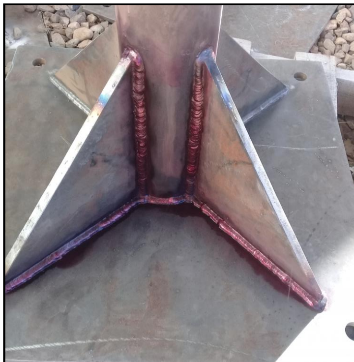
Figura 29. Prueba de líquidos Penetrantes a base de la ménsula de la Tea.
