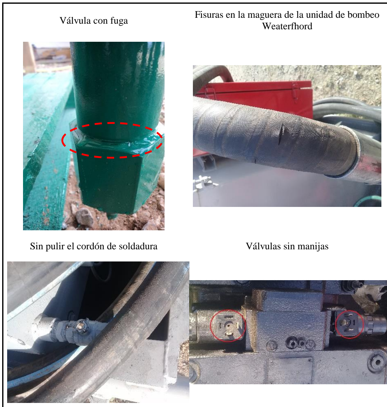
Figura 56. Inspecciones en áreas correspondientes a los procesos de construcción.
