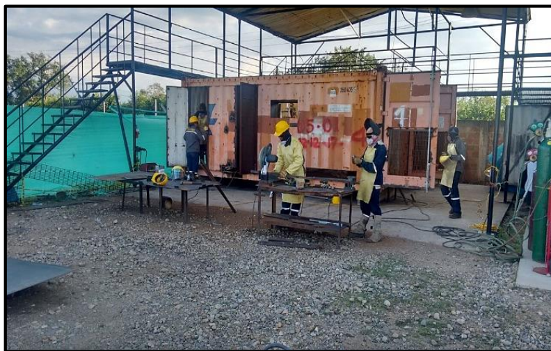
Figura 19. Área de soldadura
