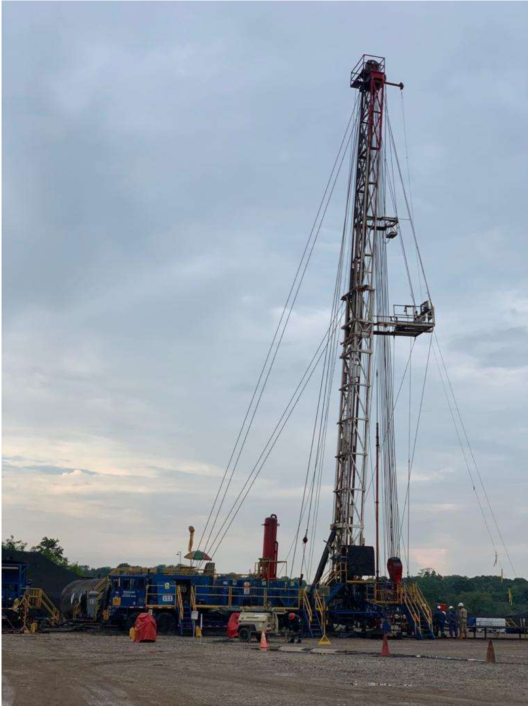
Fotografía 7 Monitoreo de mantenimiento.
