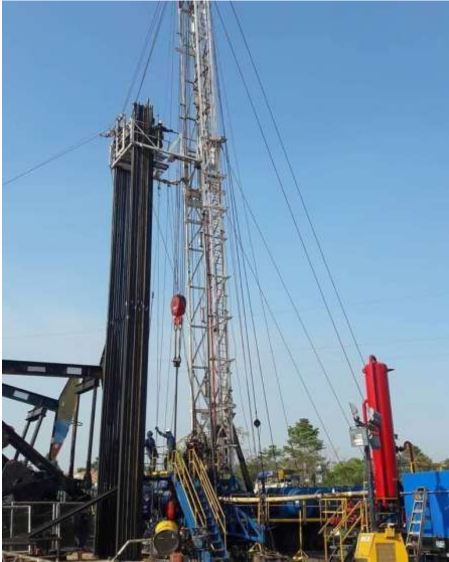
Fotografía 6 Monitoreo de mantenimiento.
