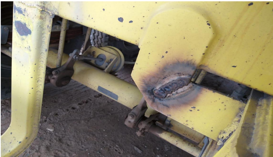
Figura 32. Soldadura chasis P10-SXS180.
