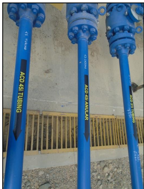
Figura 5. Instalación de demarcación y acabado de pintura. Elaboración propia (2020).
