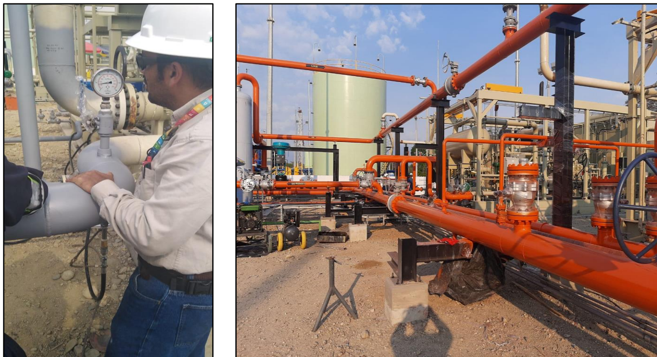
Figura 2. Prueba neumática. Elaboración propia (2020).
