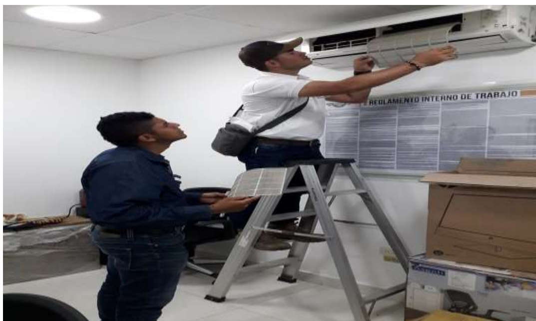
Figura 30. Mantenimiento preventivo del sistema de aire acondicionado. (Autor)
