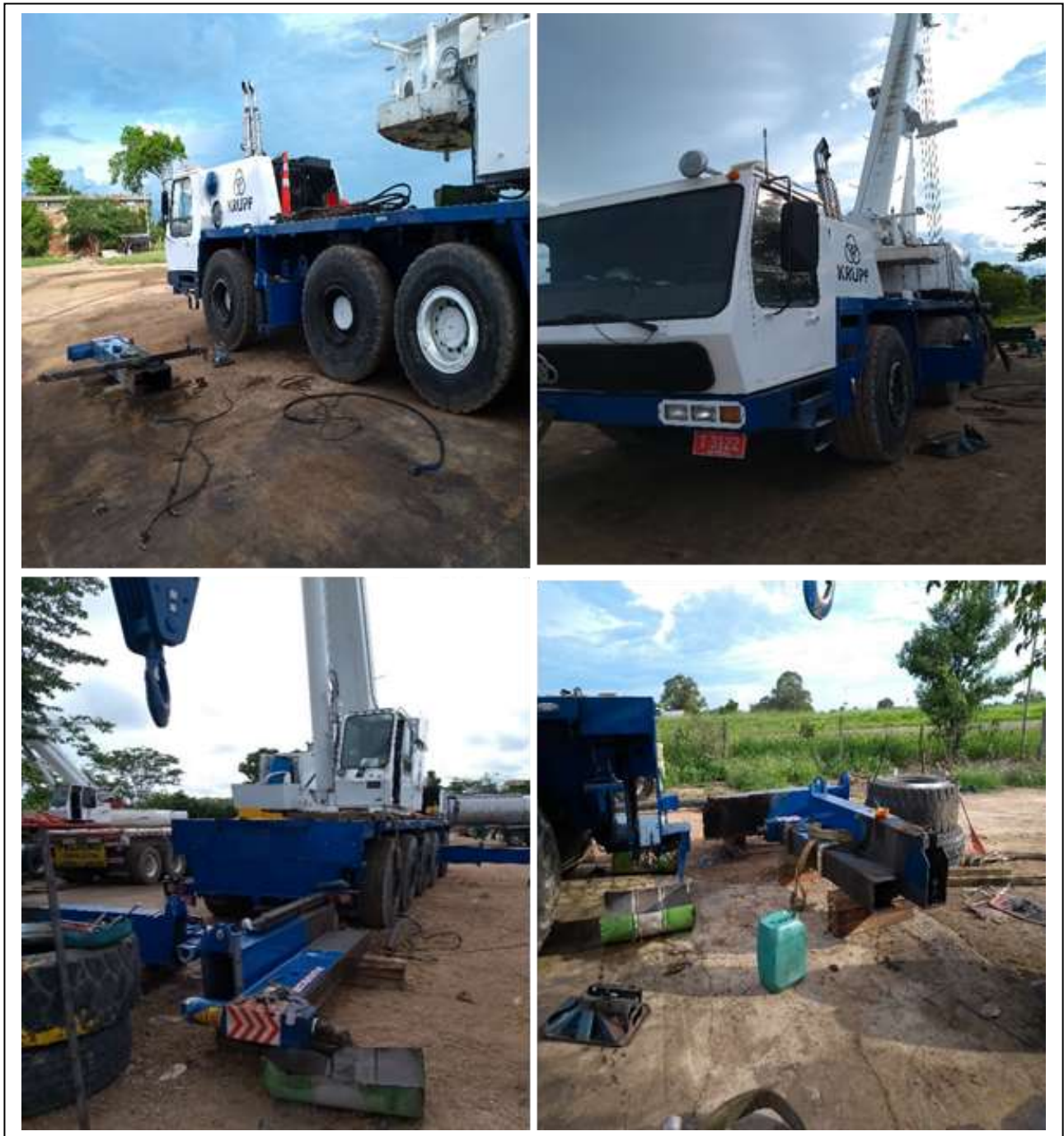
Figura 32. Mantenimiento de barras estabilizadoras de la grúa T-3122. (Multigruas,2020)
