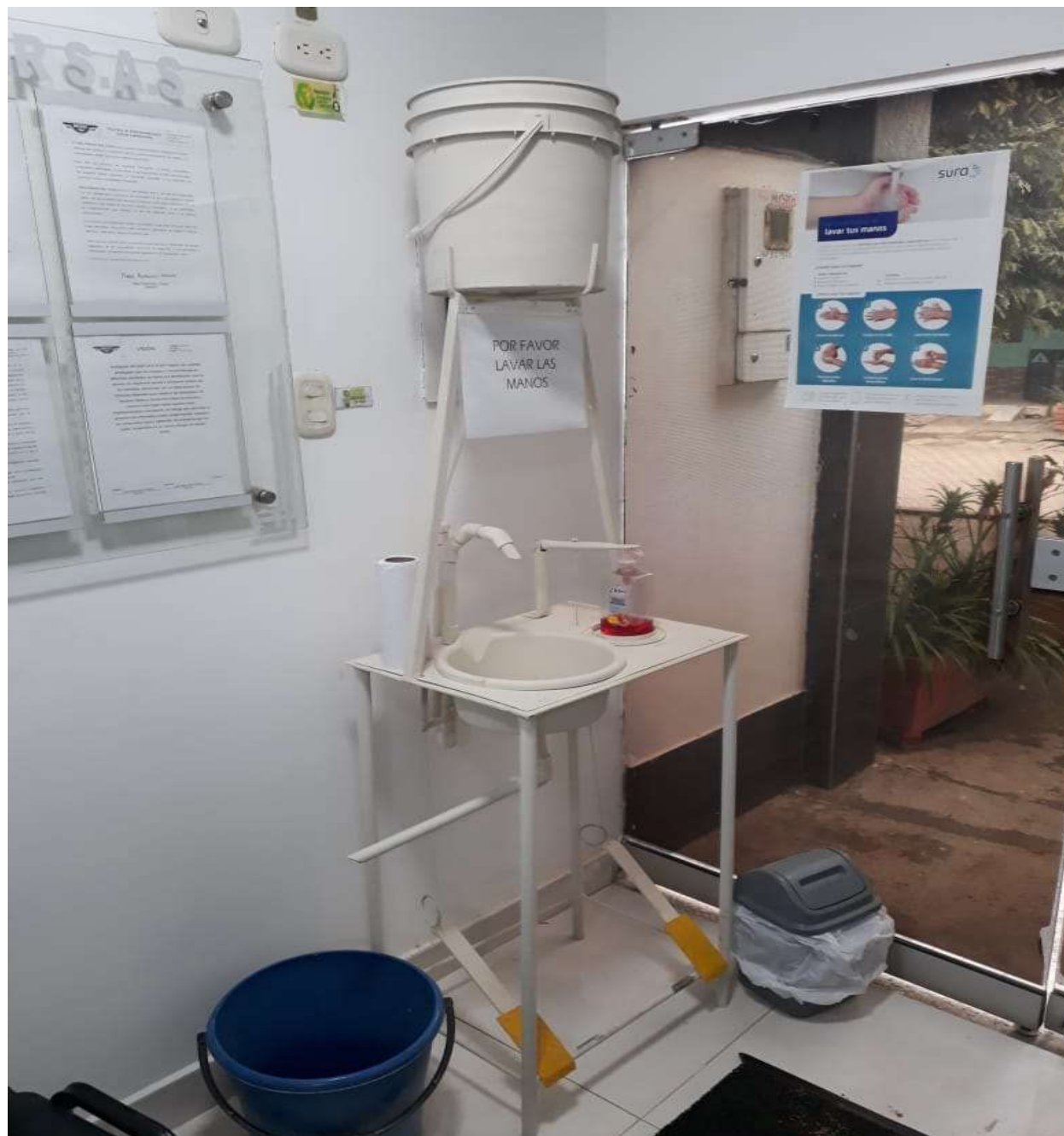
Figura 37. Instalación de punto lavado de manos. (Multigrúas, 2020)
