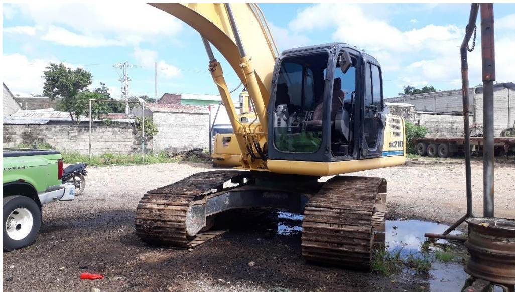
Figura 13: Excavadora Kobelco. Pasante. (2019)
