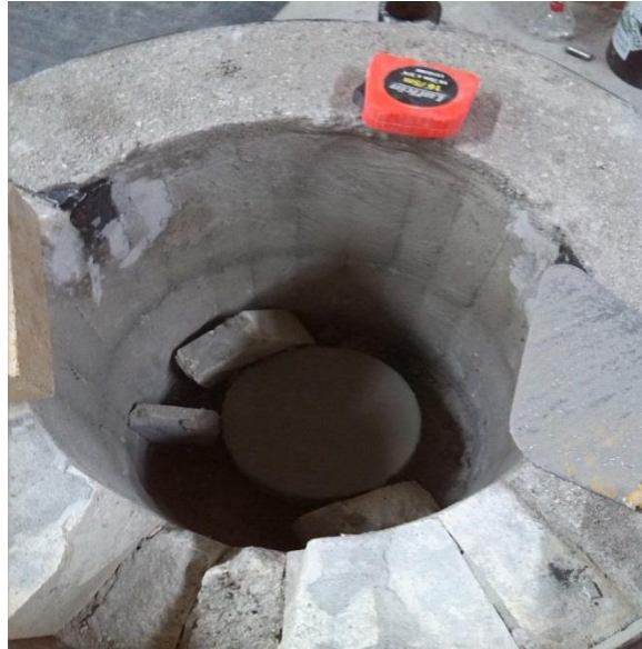
Foto 6. Montaje de pared refractaria
