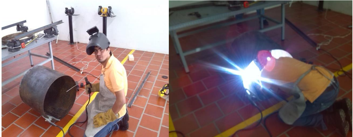
Foto 1. Construcción del cilindro metálico.
